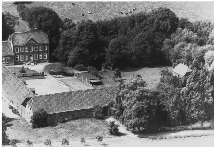
Die Gesamtanlage Gut Nottbeck vor Renovierung und Ausbau
