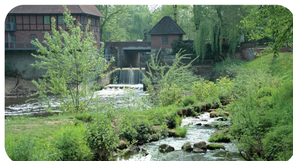
Emswehr in Telgte mit Fischaufstiegshilfe (rechts) [Stadt Telgte]
