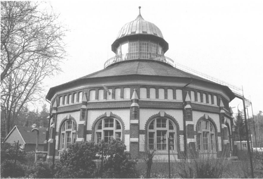
Wasserwerk Hohe Ward
