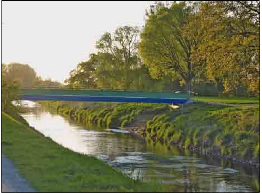
Die neue Emsbrücke im Westen der Stadt
