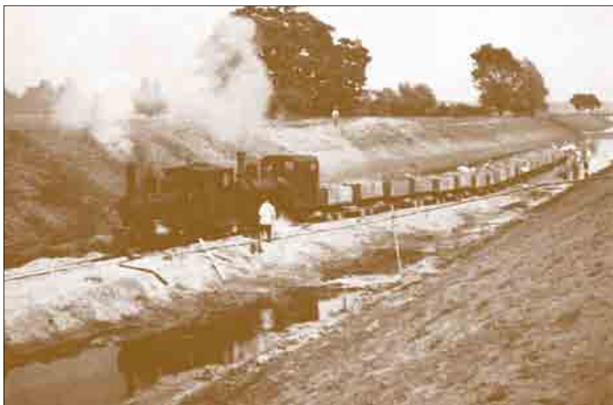
Ausbauarbeiten westlich von Warendorf 1932 – 1935
