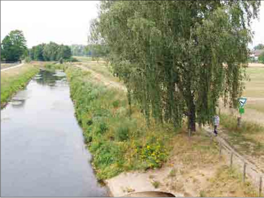
Blick von der André-Marie-Brücke auf die regulierte Ems
